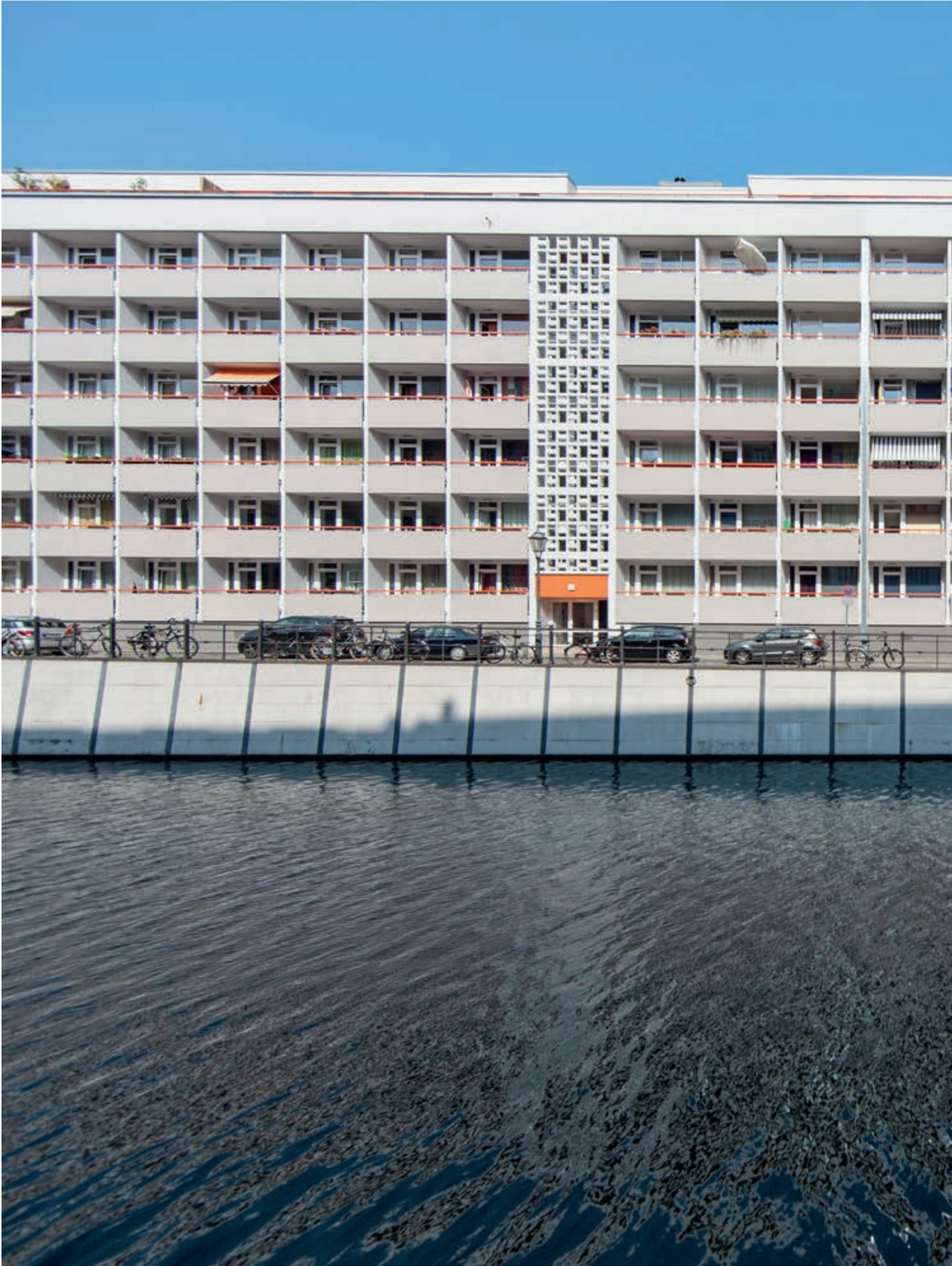
Wohnbebauung an der Friedrichsgracht auf Höhe des zukünftigen Pflanzenfilters zur natürlichen Reinigung des Spreewassers
